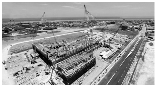
■新病院建設の様子
